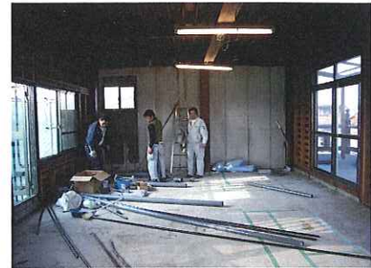
配管打合せ 遠くからみたら男前3人衆
