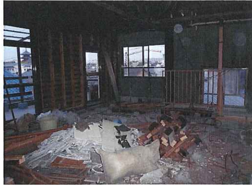
解体中 ゴミを分別してます
