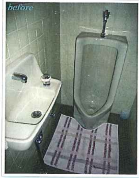
小便器をタンクレス トイレに取り替えるんだ
