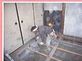
畳をフローリングに施工中
