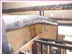
残す梁、新しい梁活かせるものは活かします！
