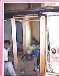
トイレ、洗面、浴室の入り口柱抜き替え中
