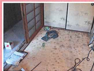
畳をフローリングに施工中
